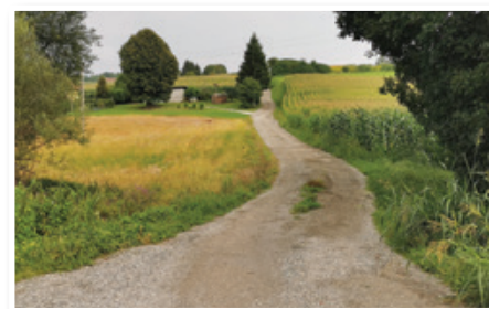
4. faza rekonstrukcije občinskih cest se bo pričela z rekonstrukcijo cestnega odseka v Zg. Partinju.
